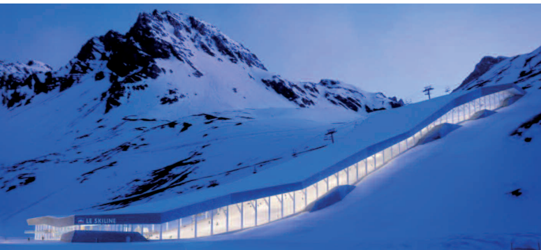
PROJET COMPLEXE SKI-LINE - TIGNES - MASSIF DE LA VANOISE © DE JONG ARCHITECTES
